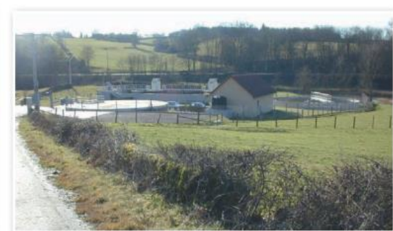
Stations d'épuration de type boues activées
