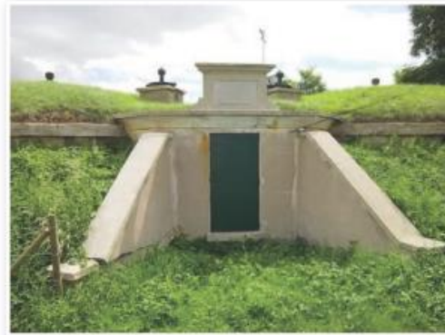
Entrée d'un réservoir semi-enterré
