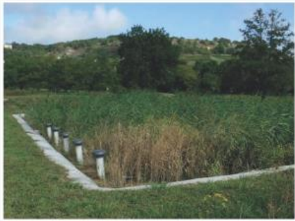
Étages de filtres plantés de roseaux
