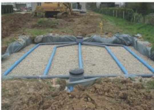
— Filtre à sable vertical drainé avant remblaiement —
