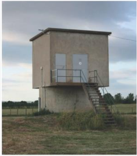
Puits de captage en nappe alluviale
