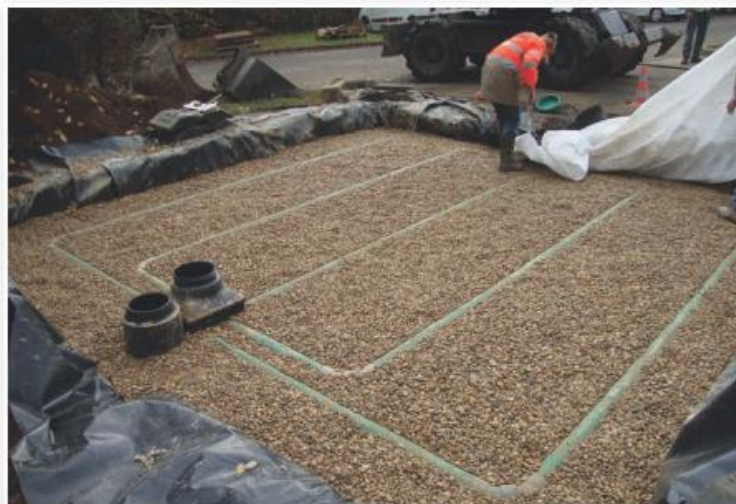
— Contrôle d'une installation neuve par un technicien SPANC —
