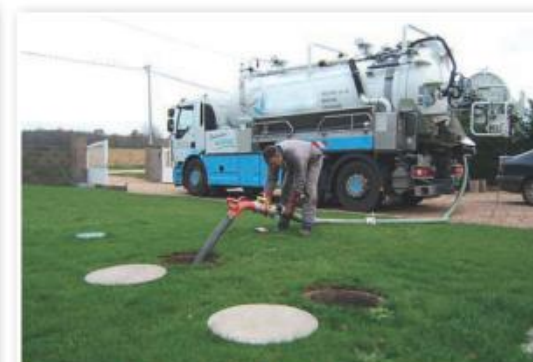
— Vidange d'une fosse toutes eaux —
