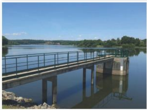
Prise d'eau dans une retenue superficielle
